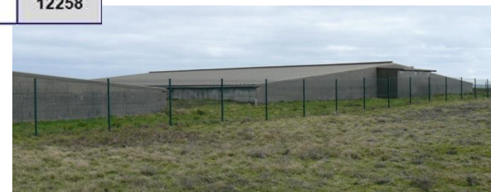
Site des réservoirs à l'ouest de l'île
